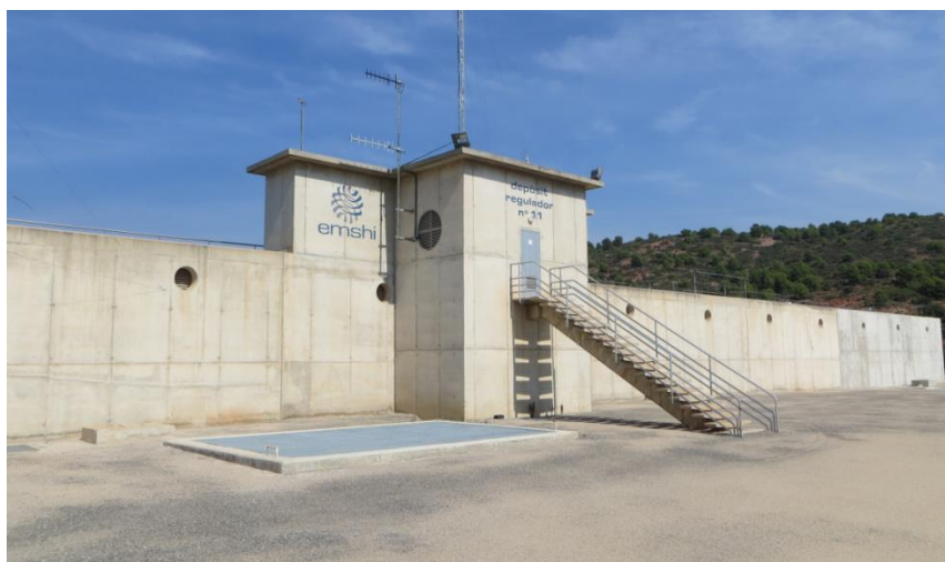
Imagen 1. Vista del depósito regulador nº11 del EMSHI ubicado en el término municipal de Puçol
